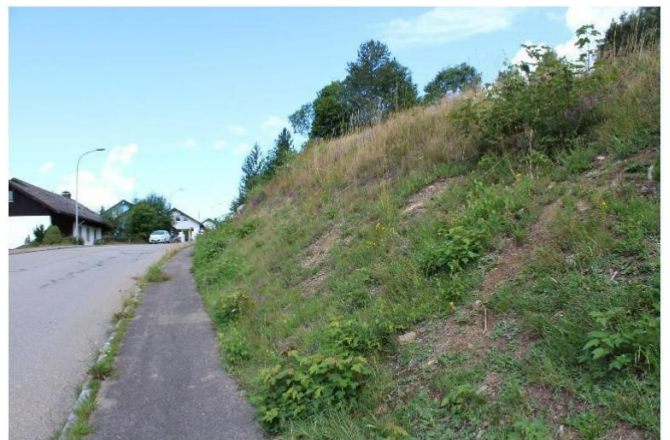
Böschung im Süden
